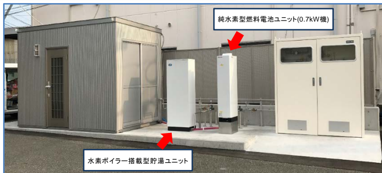
純水素型燃料電池ユニット(0.7kW機) 水素ボイラー搭載型貯湯ユニット 純水素型燃料電池コジェネレーションシステムの実証試験
