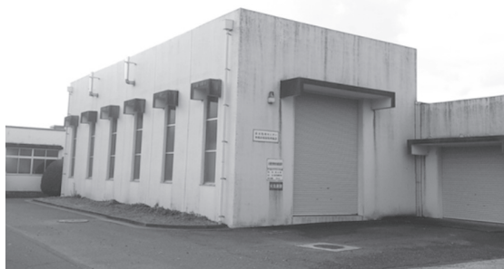
写真12 排水処理施設（吉田地区）
