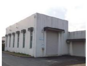
排水処理施設
