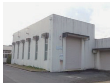
排水処理施設
