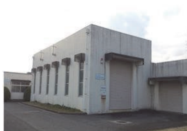
排水処理施設
